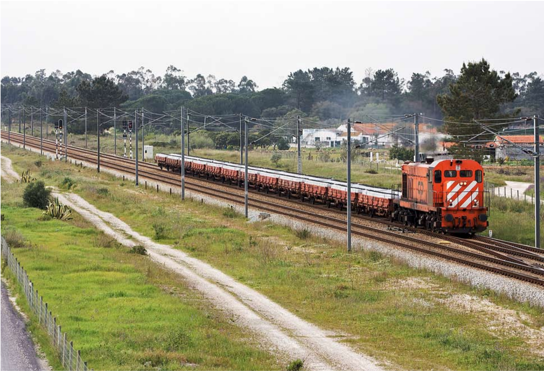
Bygge dobbeltspor. «Arbeidsløse franske og spanske anleggsarbeidere kunne få opp farten med å bygge dobbeltspor vi så svært trenger», skriver Dag Seierstad. Bildet viser et tog lastet med sviller på vei til en jernbaneutbygging i Setúbal i Portugal.
