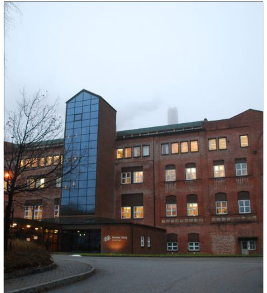
KAN BLI RAMMET: Saugbrugs i Halden kan bli rammet hvis EU får kontroll på norsk energipolitikk, skriver Arve Sigmundstad. FOTO: HERMUND KJERNLI
